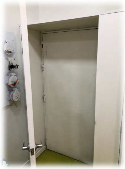
PUERTA ASEO Espacio futura cocineta
