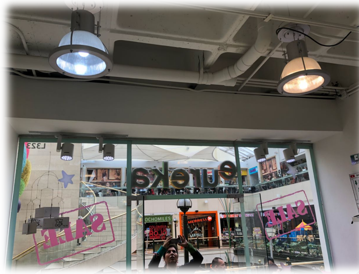
FOTO HACIA EL EXTERIOR Detalle de cielo y acometidas eléctricas
